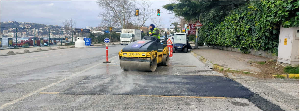
İNF.AS.YAMA aracı ile yapılan yamanın silindirle sıkıştırma işlemi
