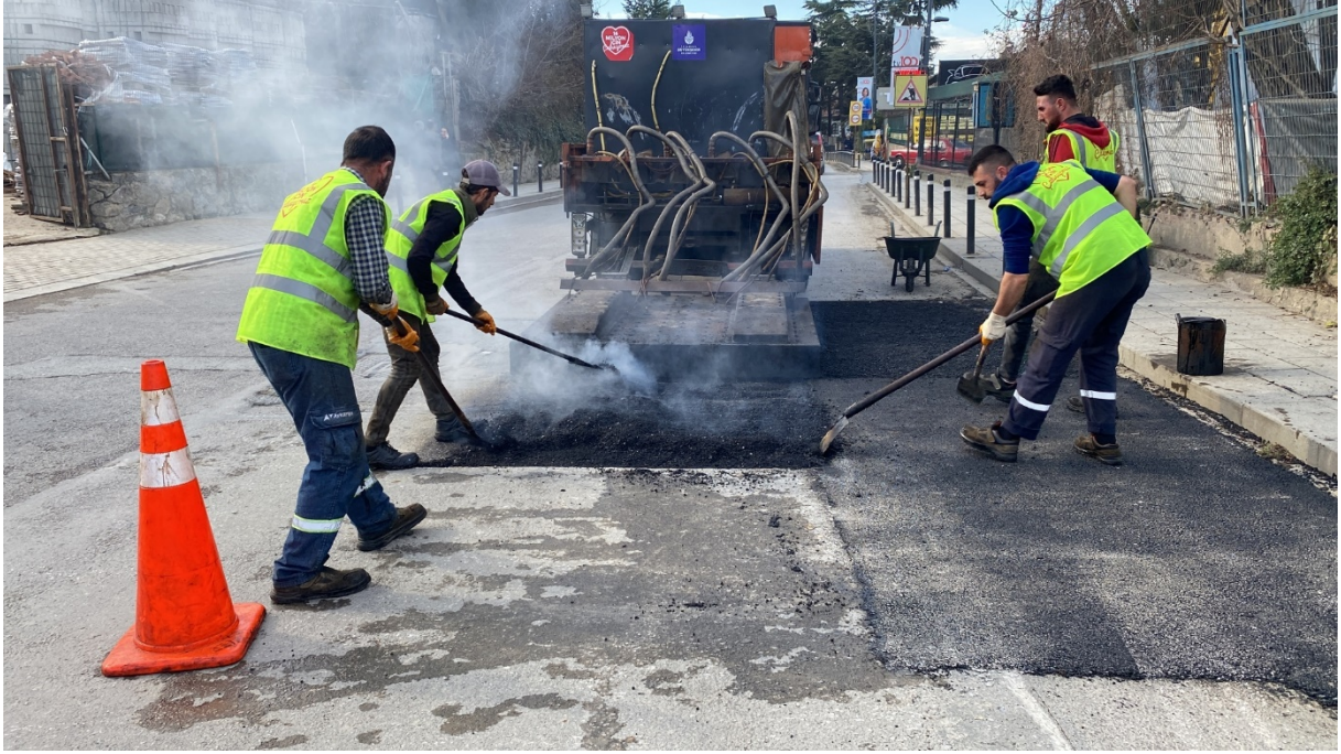
İNF.AS.YAMA aracı ile yapılan yama çalışması
