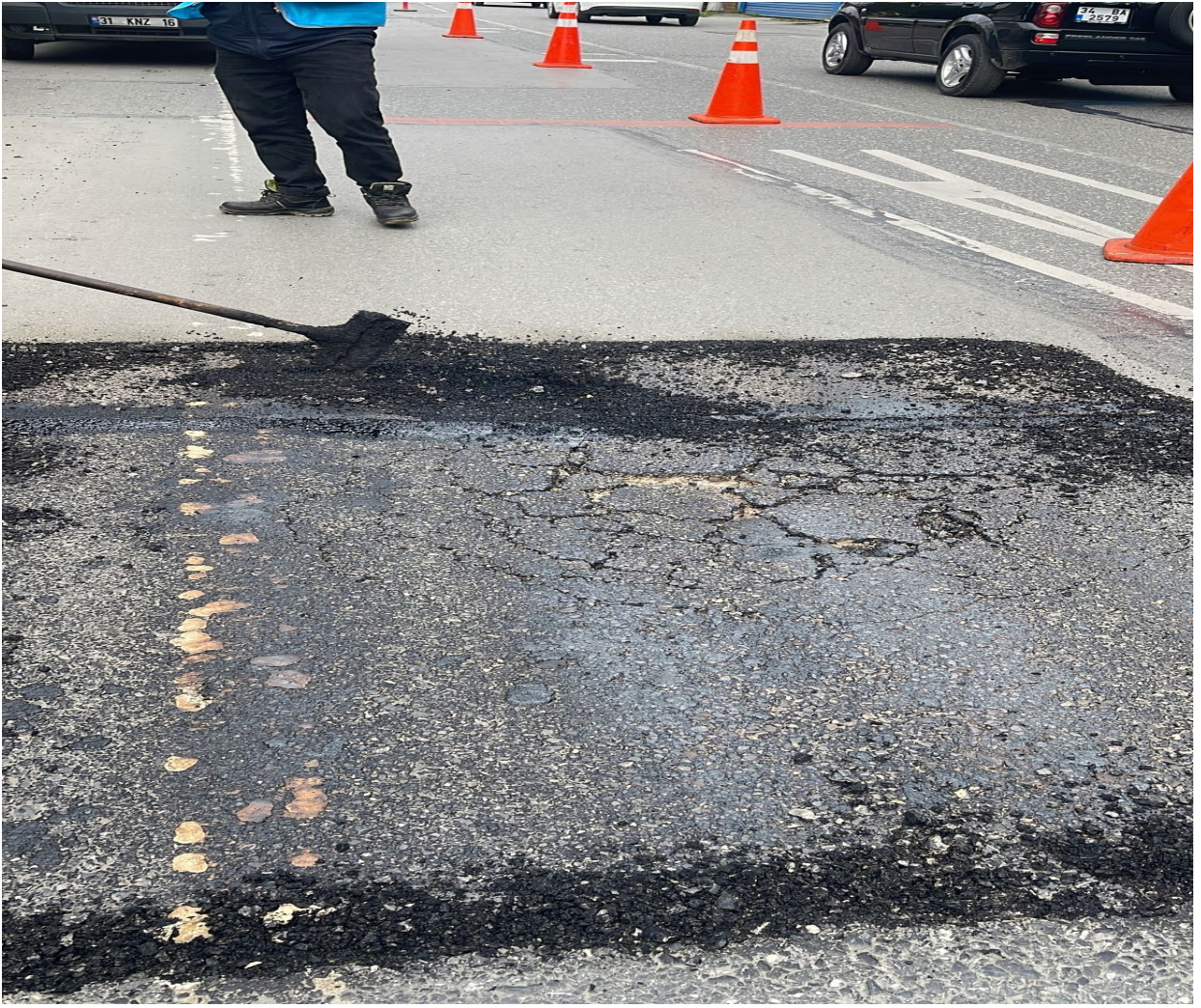
İNF.AS.YAMA aracı ile ısıtılan asfaltın kazınmaya başlanması
