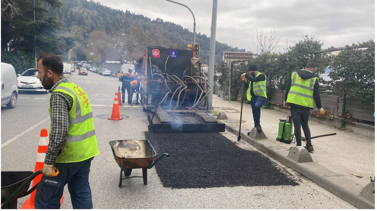
İNF.AS.YAMA aracı ile yapılan yama çalışması
