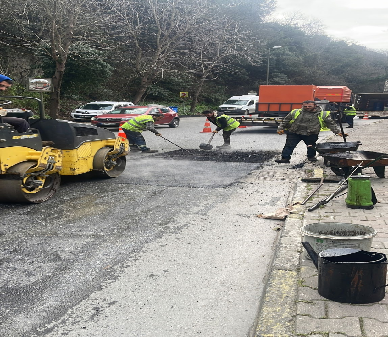
İNF.AS.YAMA aracı ile yapılan yama çalışması
