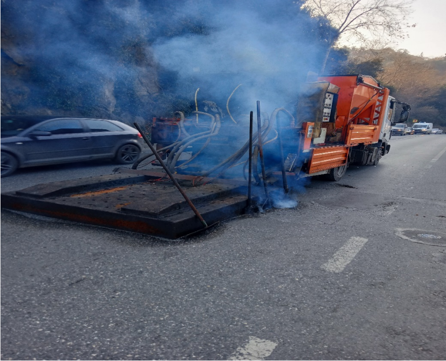
İNF.AS.YAMA aracı ile yapılan asfalt ısıtma işlemi
