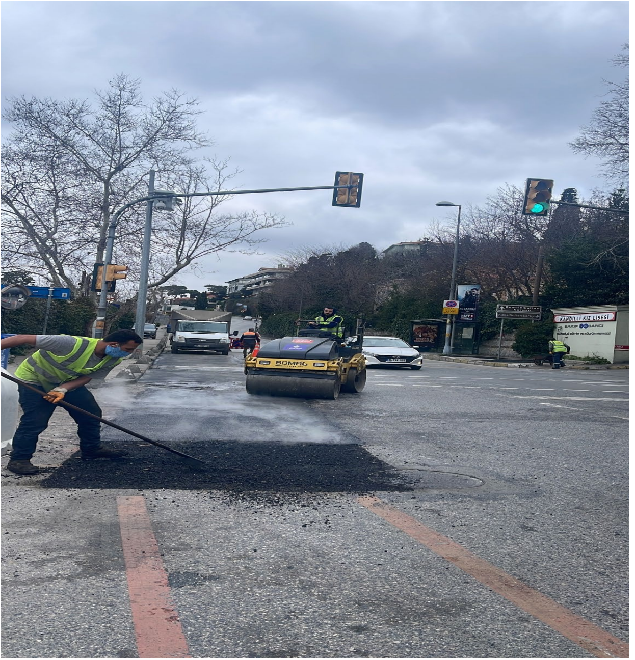
İNF.AS.YAMA aracı ile yapılan yamanın silindirle sıkıştırma işlemi
